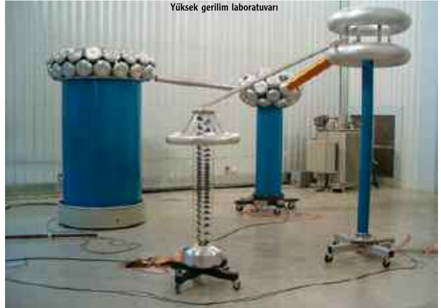
Yüksek gerilim laboratuvarı
